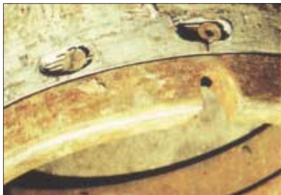
A maghenger feszültsége következtében a rögzítőcsavarok furatai megnyúltak, és a menetesen rögzített acél csőkarmantyú kilazult.
